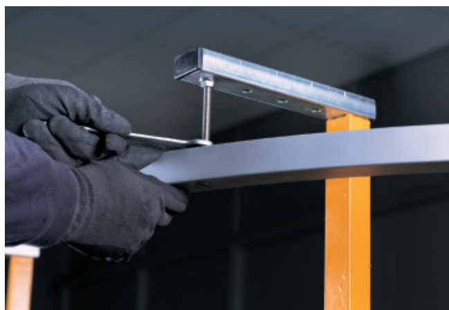
Корректировка рабочей высоты линии и выставление ее по горизонтали с последующей затяжкой подвесных креплений.
