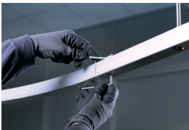
Затяжка соединений секций осуществляется с помощью двух болтов, данная операция повторяется до окончания линии.
